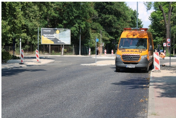
skrzyżowanie w trakcie robót
